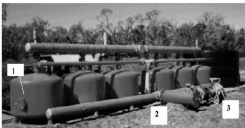
Сн. 1 Филтърен блок : 1. Пясъчно-чакълест филтър 2. Мрежест филтър 3. Торосмесител
